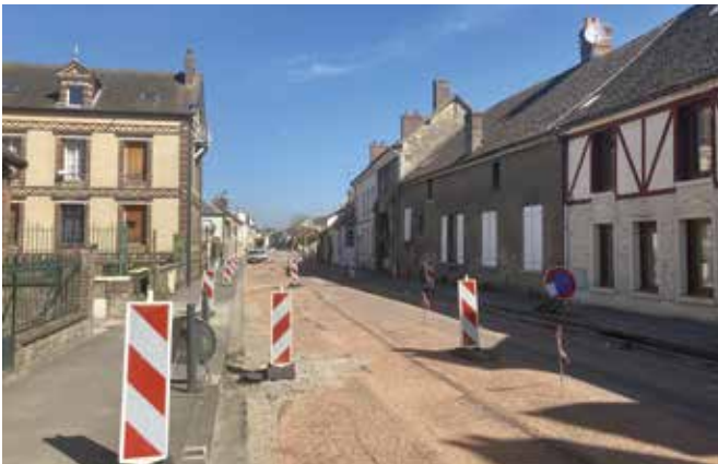
Les travaux de voirie entrepris rue de la Libération à Gisors entrent dans le cadre des investissements prévus au budget 2021
